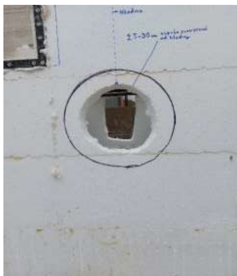
Příprava a osazení předmontážní sady protiproudu.
